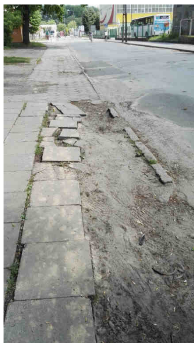
Fotografie: Przykłady ubytków i złego stanu technicznego jezdni i chodników obszaru śródmieścia, ulice Kościelna, Kościuszki, Żwirki, Żeromskiego, Traugutta, Listopadowa
